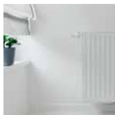
Riscaldamento con radiatori a bassa temperatura
